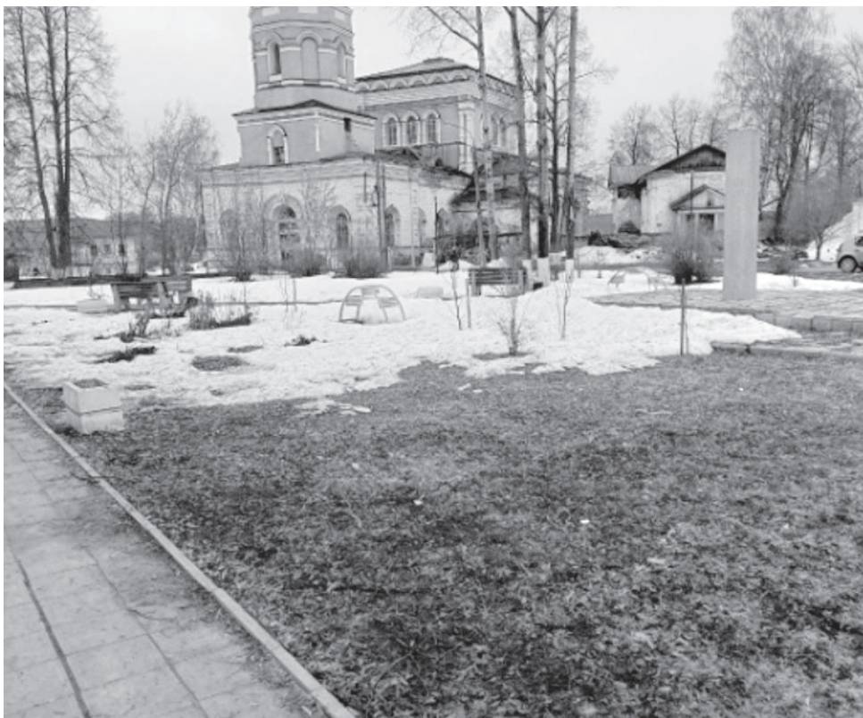
📷 В рамках благоустройства сквера в п. Павловский планируется обновление пешеходного тротуара, установка малых архитектурных форм (ла-вочки, урны), озеленение
