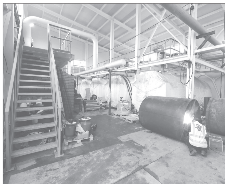
В Верещагино продолжается комплексное обновление систем теплоснабжения. Согласно условиям контракта, подрядной организации предстоит выполнить закольцовку тепловых сетей между новыми объектами, чтобы обеспечить подачу горячего водоснабжения потребителям круглый год.
