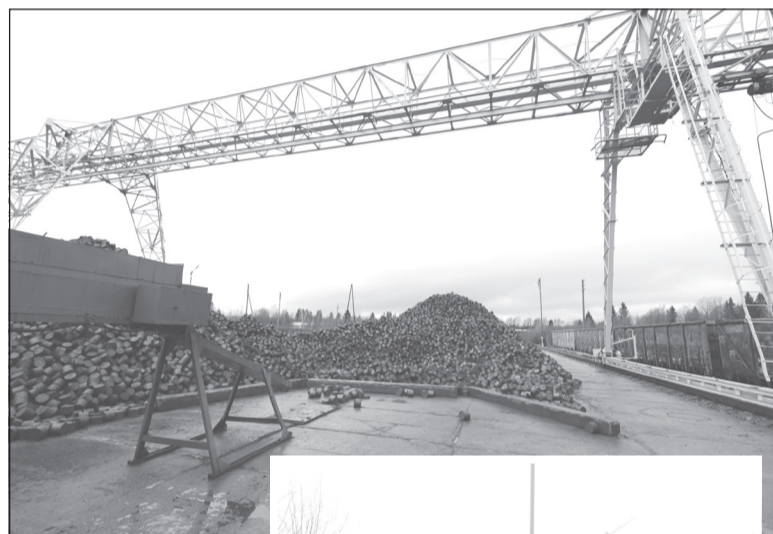
Чтобы запустить современную линию по переработке металлостружки, «Агросервису» пришлось выкупить и отремонтировать железнодорожный тупик.
