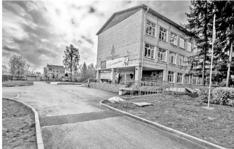
В Мулянке отремонтирован школьный двор
