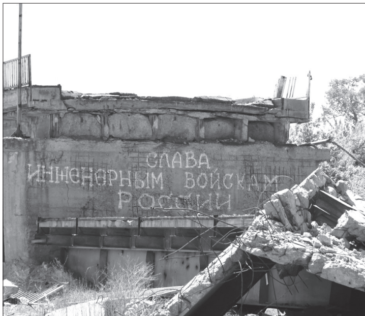
Разбитые капитальные мосты заменяются пока что временными сооружениями. / ФОТО АВТОРА
