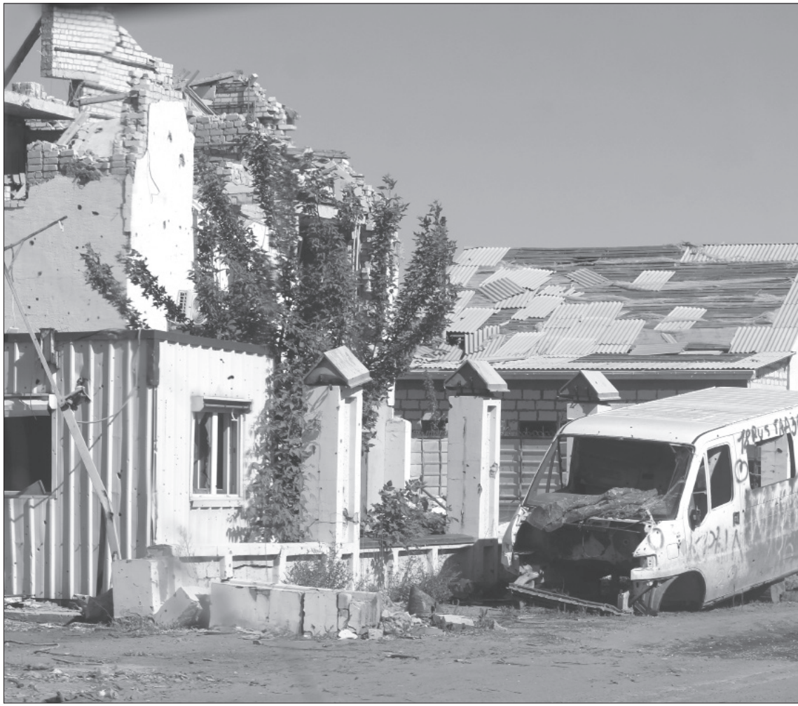
Чем ближе к линии боевого разграничения, тем больше разрушенных домов и повреждённых автомобилей. / ФОТО АВТОРА
