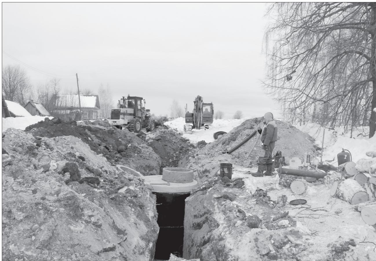
**В округе продолжается ремонт водосетей. Прошлым летом в Орде капитально отремонтировали более 8 км водопровода. В этом году подрядчик начал менять трубы ещё на одном участке значительно раньше срока. Замениено около 500 м водопровода по улице Верхней в деревне Серкино. Рабочие установили колодец для пожарного гидранта.**
