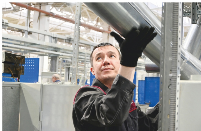
Монтаж местной вытяжной вентиляции
