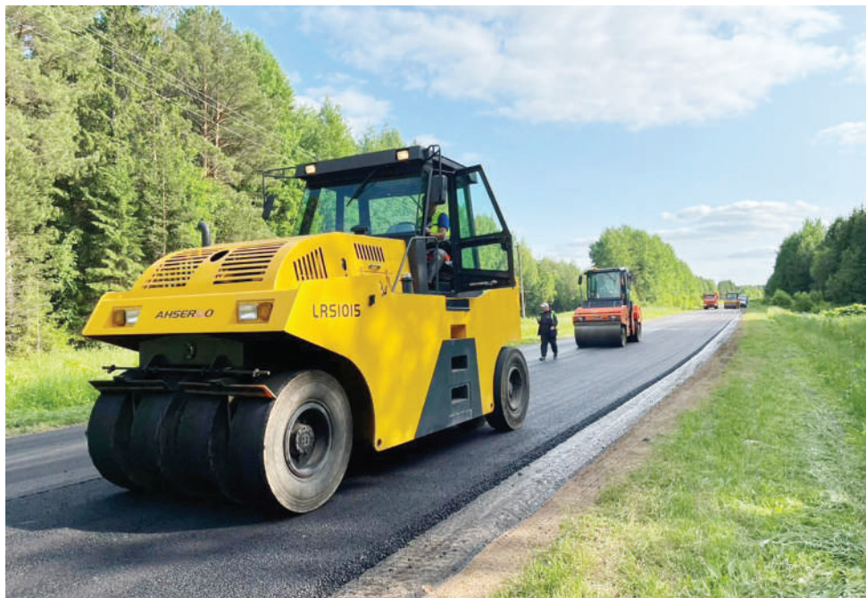
Ремонт участка дороги «Кудымкар – Ошиб».
