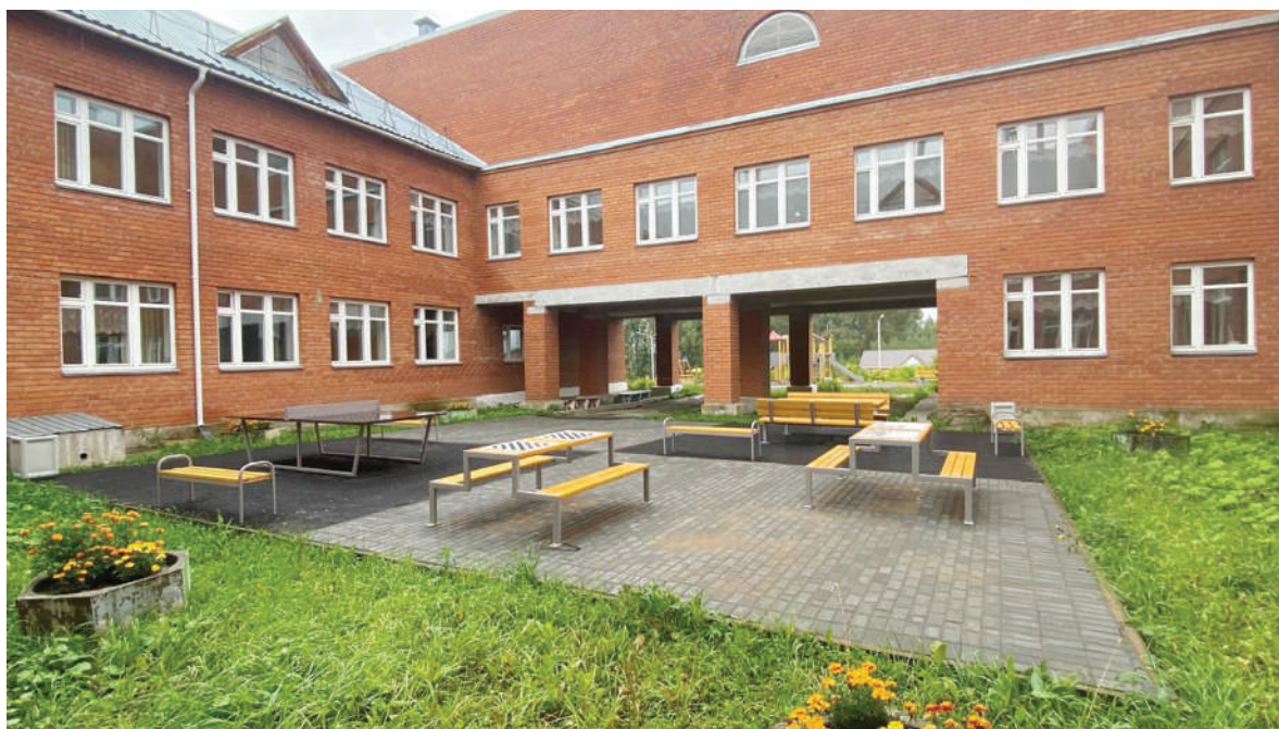
Ремонт школьной территории в селе Ошиб.
