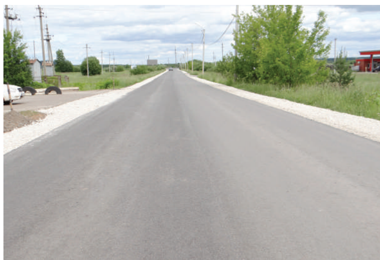
Завершён ремонт двух участков дорог, расположенных на территории города – по ул. К. Маркса и по ул. Хорошева.
