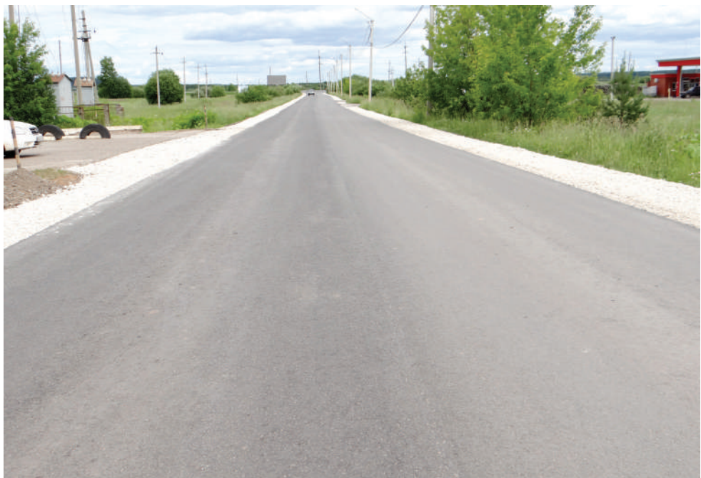
Ремонт участка дороги по улице Хорошева в Кудымкаре.
