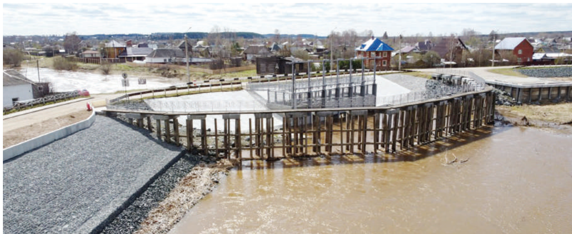
Ремонт ГТС на реке Кува.
