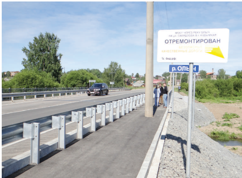
Мост через р. Олыч в г. Кудымкаре капитально отремонтирован в 2024 году.
