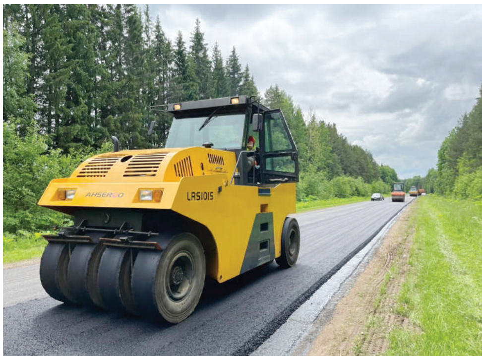
Масштабные дорожные работы идут на трассе г. Кудымкар – с. Ошиб.
