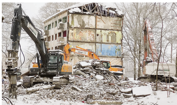
При демонтаже сносят только жилые этажи
