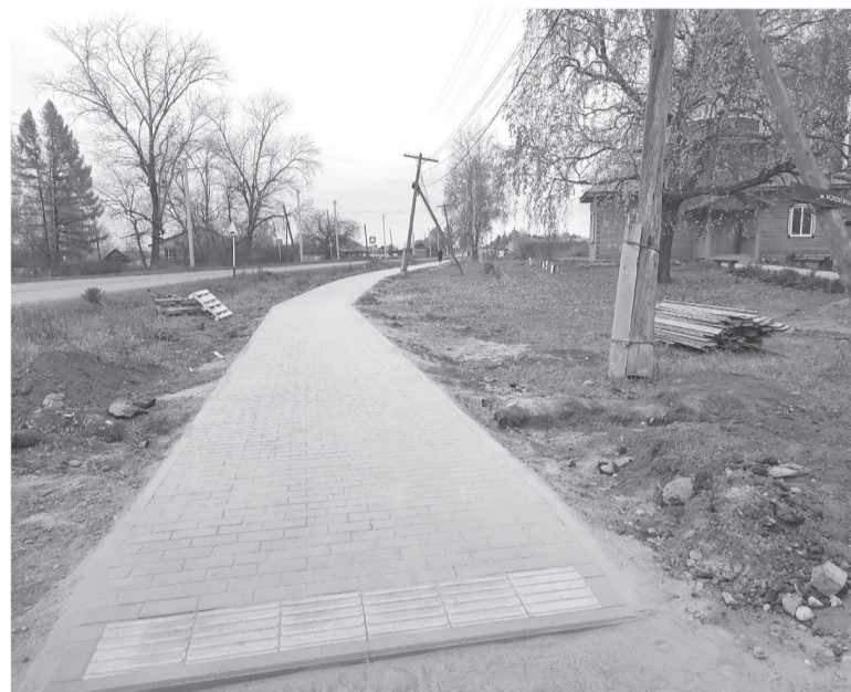
Часть улицы Голева уже отремонтирована
