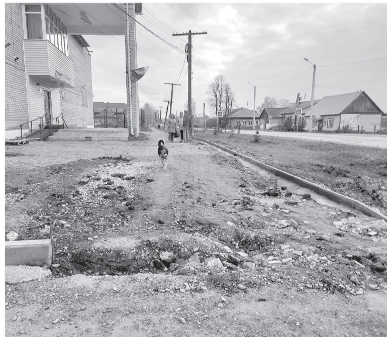
На второй половине улицы работы по укладке тротуара продолжаются
