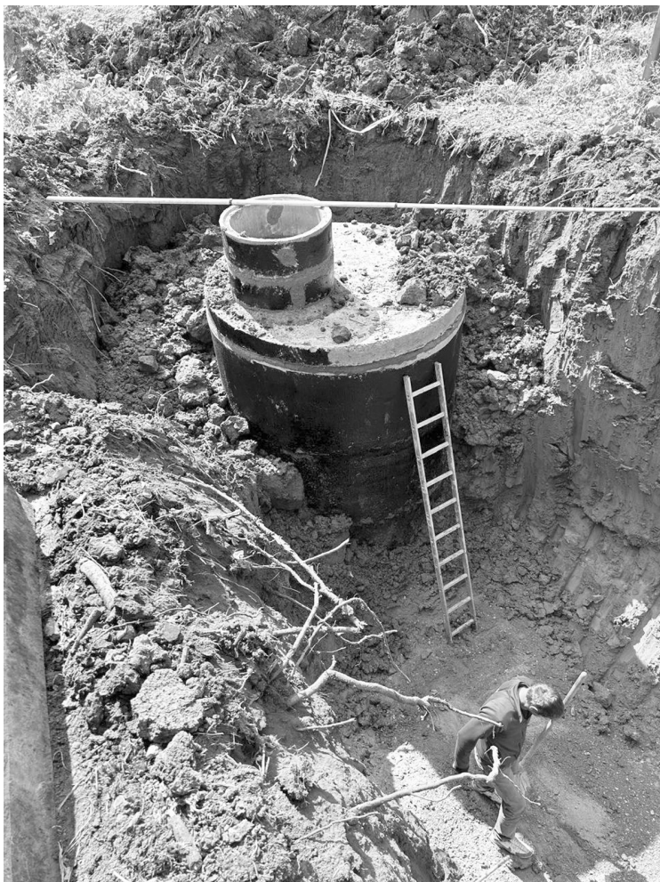
Монтаж колодцев инженерных сетей
