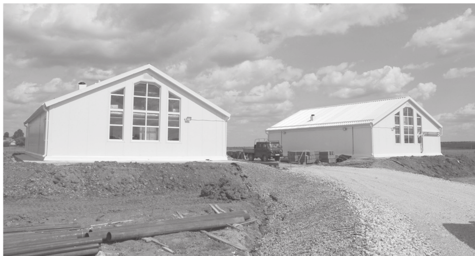
В Юсьвинском муниципальном округе завершено строительство очистных сооружений
