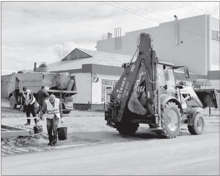
Рабочие проливают битумом участки под асфальтирование. ФОТО: СТРАНИЦА АЛЕКСАНДРА МЕЛЁХИНА, ВК
