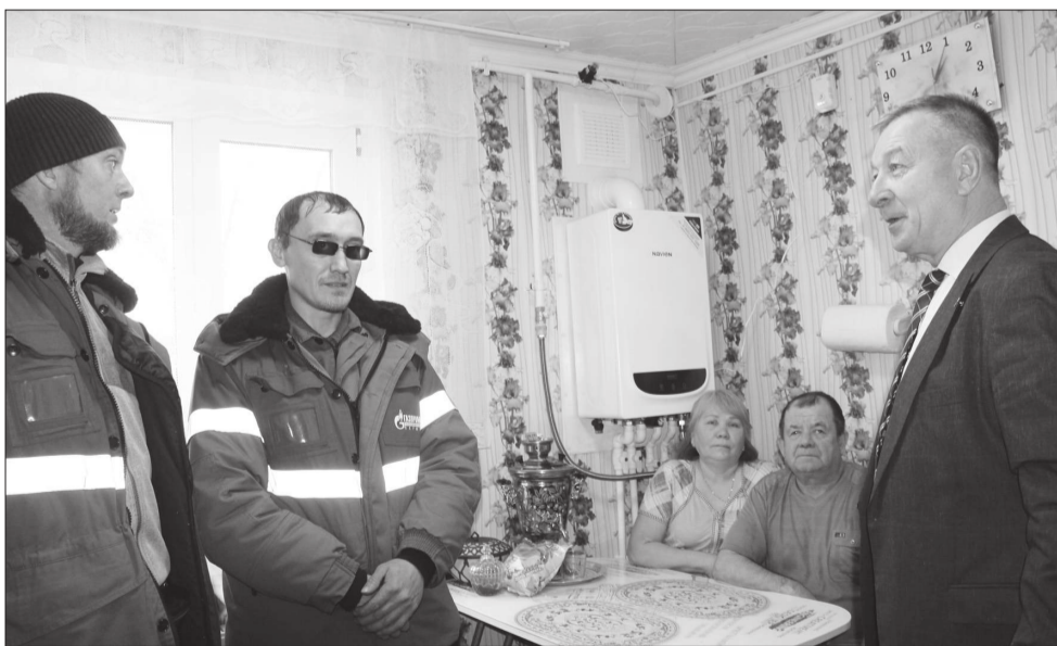
Новую газовую колонку с полной автоматикой запустили сотрудники Управления газового хозяйства Чайковского филиала АО «Газпром газораспределение Пермь» А.С. Ворзоносов и А.А. Садрисламов. / ФОТО: Н. БОГДАН, «ВПЕРЕД»
