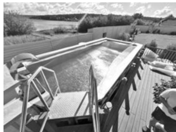
Бассейны из нержавеющей стали более удобны в обслуживании, чем обычные бетонные, облицованные плиткой, мозаикой или плёнкой ПВХ. Стальные бассейны более устойчивы к влиянию химически агрессивной (например, минерализованной или морской) воды и сезонным перепадам температуры, не требуют специального ухода против болезнетворных микробов и сложной зимней консервации. Они также могут быть любой формы, для них не нужны дополнительные работы по гидроизоляции и отделке чаши.
