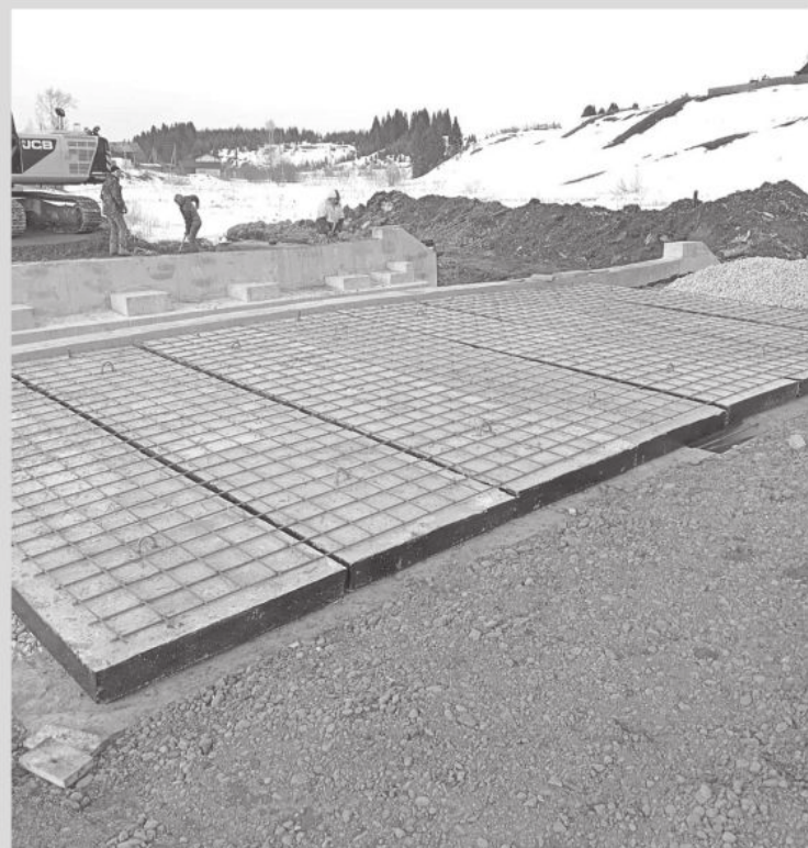
В посёлке Майкор в рамках нацпроекта «Безопасные качественные дороги» полным ходом идет капитальный ремонт моста через р. Сельковка. Фото: https://vk.com/ngnikulin
