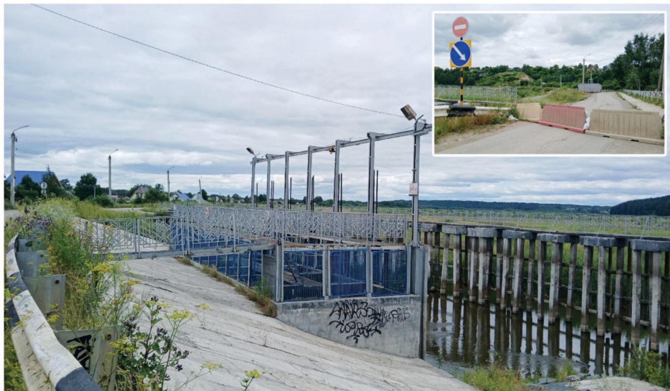
До 15 мая 2025 года подрядчик должен провести ремонт шлюзов и сделать берегоукрепление. Фото Ирины Шипицыной
