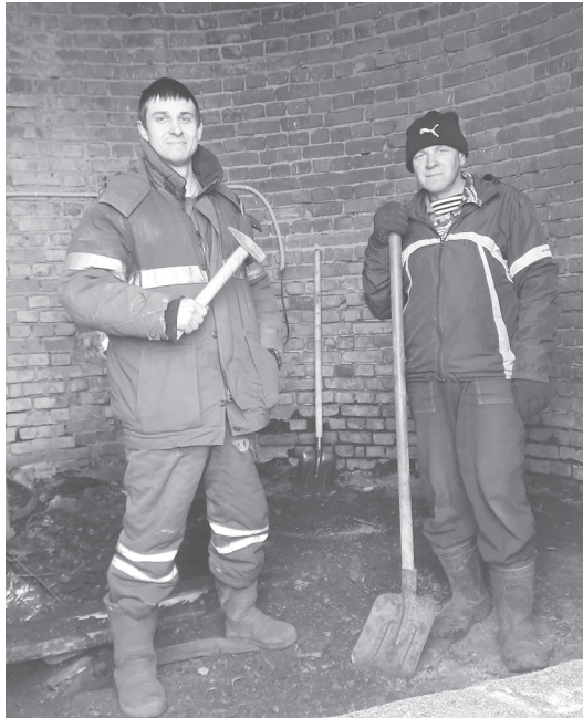
Работы на водонапорной башне в Елово идут полным ходом. Их ведут Евгений Исаков и Николай Сельницын из Куединского округа
