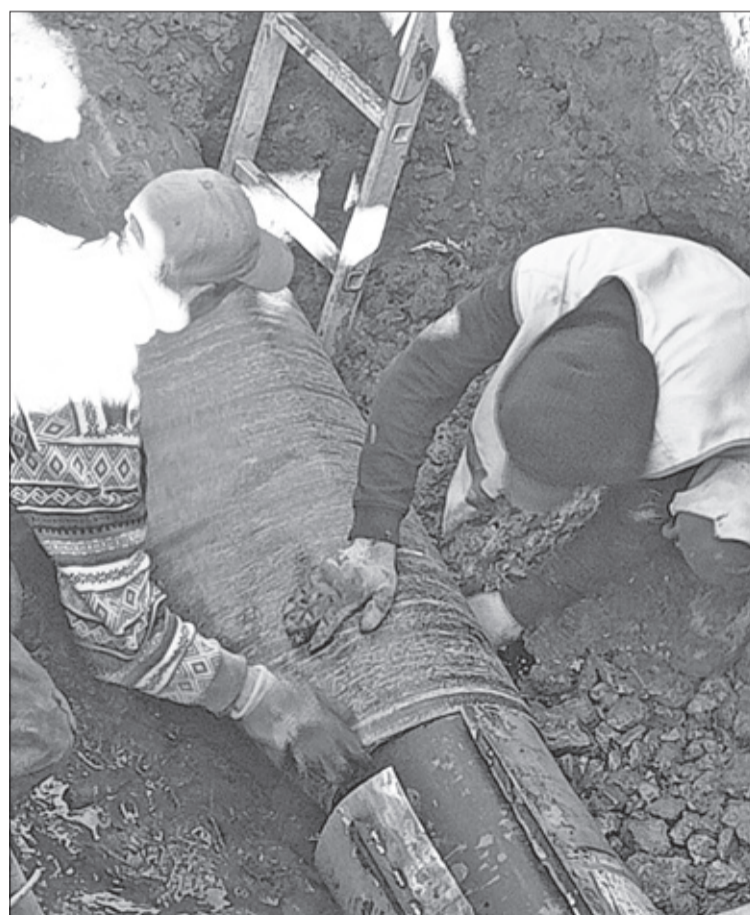
Работники МБУ «Благоустройство» в начале сентября отремонтировали ливневую канализацию на участке ул. Энергетиков.
