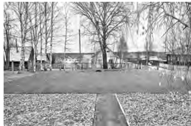
Спортивная площадка в Родниковском детском саду на стадии строительства и обустройства
