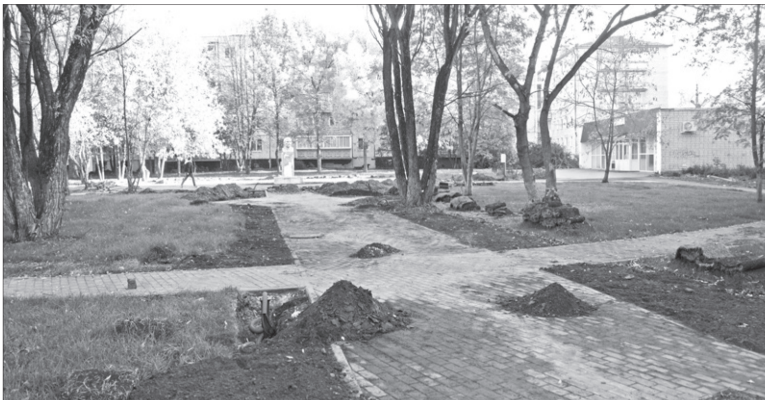
К 14 сентября работы в сквере у кафе «Марянка» ещё не завершены, хотя срок сдачи объекта давно прошёл. / ФОТО АВТОРА
