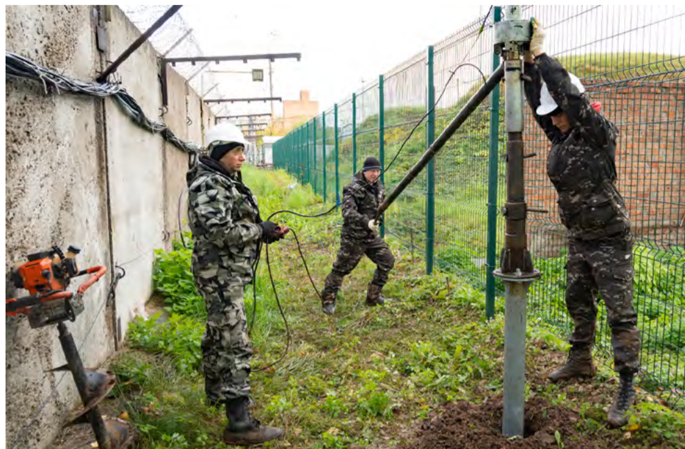
Подготовительные работы к замене оптоволокна идут полным ходом
