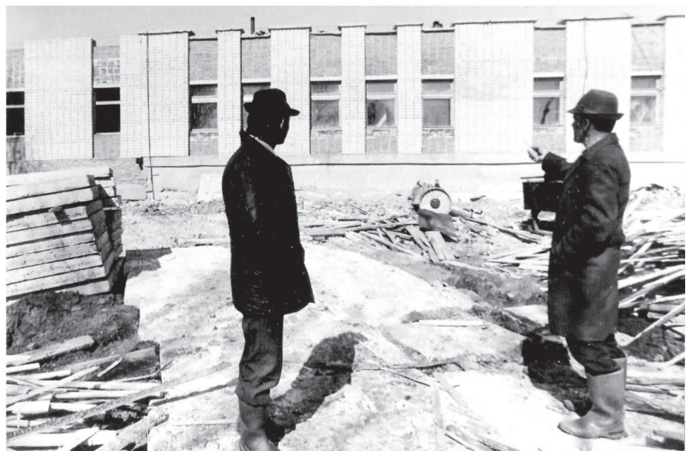
Строительство радиодома в г. Кудымкаре начато в 1988 г. Подрядчик СМУ-2 треста «Кудымкаргражданстрой», 05.05.1990
