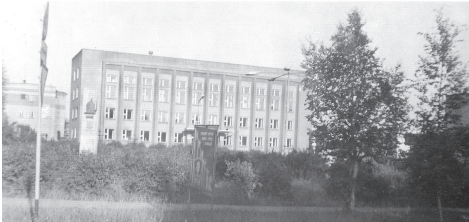
Общий вид здания Коми-Пермяцкого окружного КПСС и ВЛКСМ по ул. 50 лет Октября, 37А. г. Кудымкар, 03.07.1987
