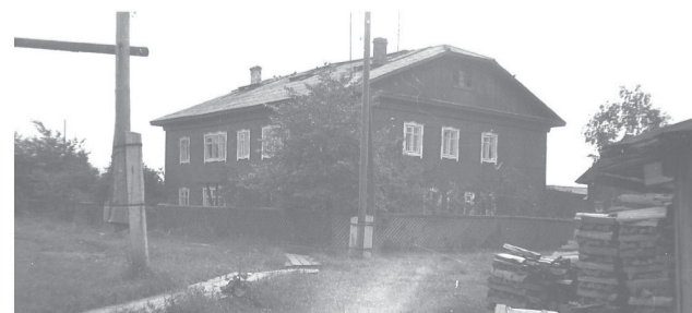
Общий вид здания Кудымкарского мехлесхоза им. Н. И. Кузнецова, 03.07.1987
