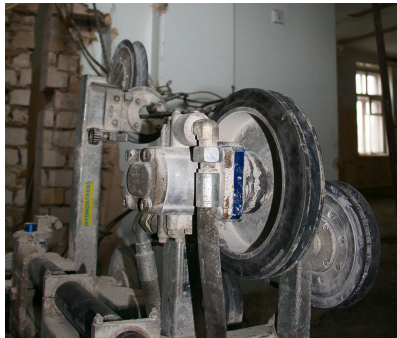
2011 год. Механизм для пропиливания деформационных швов
