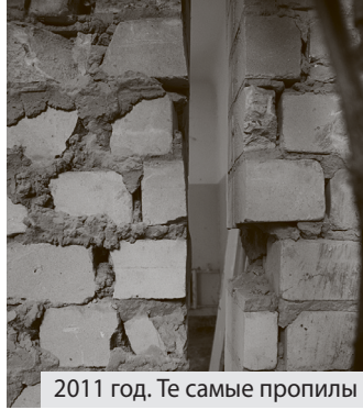
2011 год Усиление конструкций здания
