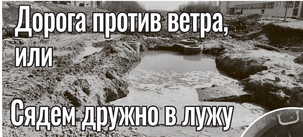
Под полотном строящейся дороги проходит затопленный коллектор
